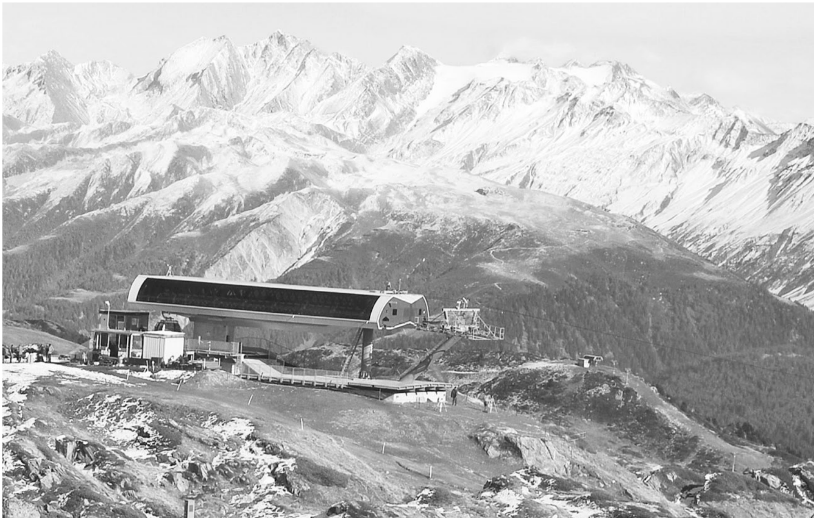
Instabiler Untergrund. Der durch geologische Setzungen entstandene Hohlraum unter dem Fundament der Bergstation Moosfluh soll soweit möglich mit Lockermaterial aufgefüllt werden.
