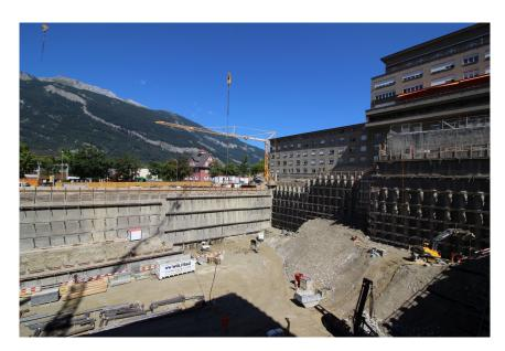
Das Erweiterungsprojekt SUN am Kantonsspital Graubünden umfasste unter anderem einen Neubau inkl. einer Tiefgarage. Die Baugrube mit einer Tiefe von bis zu 22 m grenzte teilweise direkt an das bestehende Bettenhaus. Zudem wurde eine Kanal für die Energieversorgung unter den bestehenden Gebäuden mit MRI und Operationssaal vorgetrieben.
